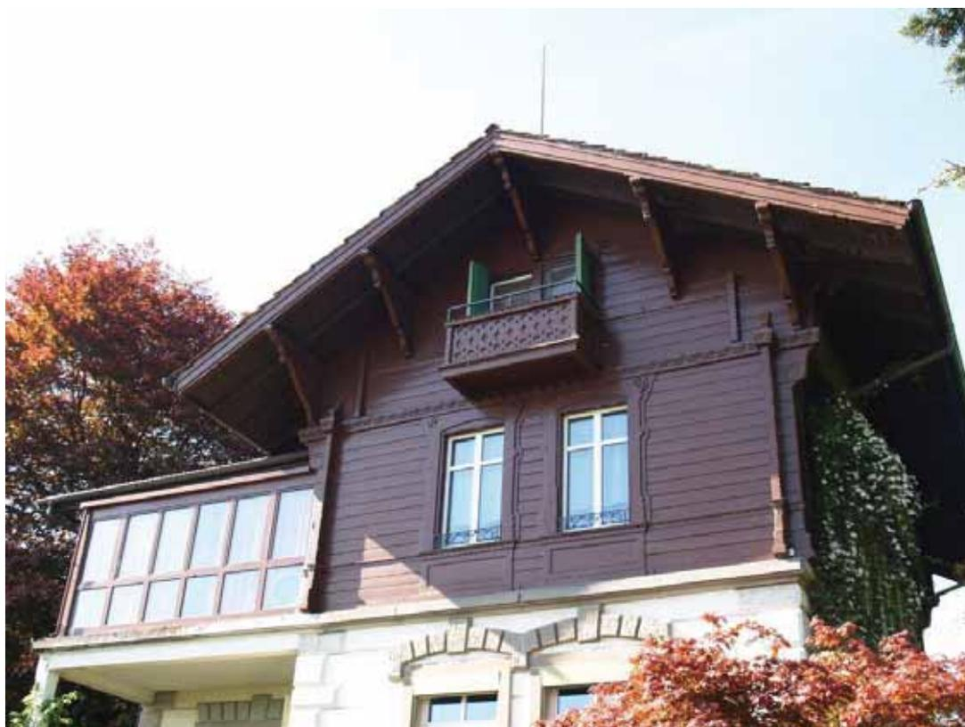
*Quergiebel der Nordfassade: Die weit herausragenden Pfetten werden durch Konsolen gestützt. Die Veranda links hätte subtiler gestaltet werden können.*
