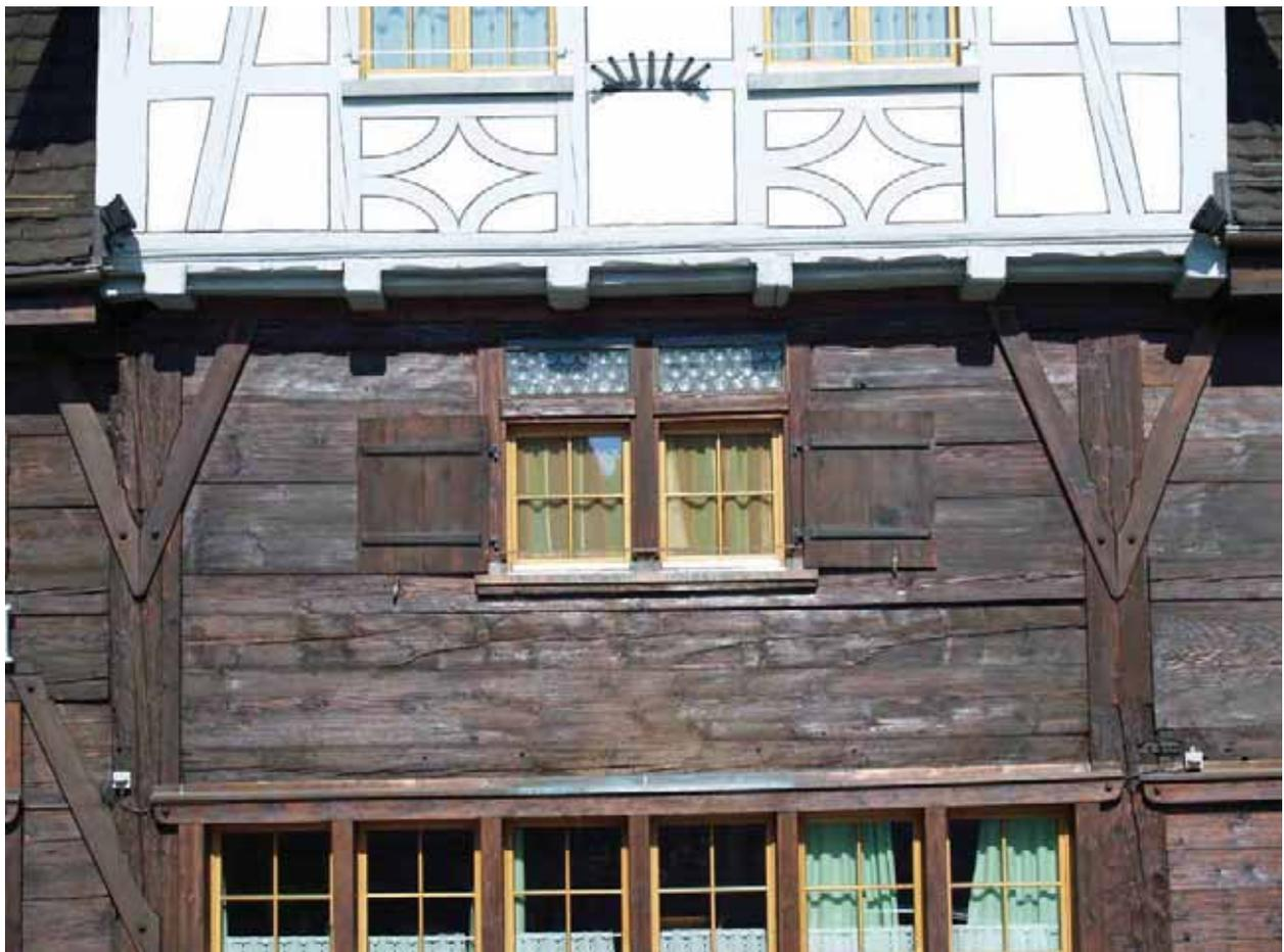
*Die Bohlenständerkonstruktion mit dem Motiv des „stehenden Mannes“. Etwas „mager“ wirkende Kipfenster mit aufgesetzten Sprossen, darüber rekonstruierte Butzenscheiben.*
