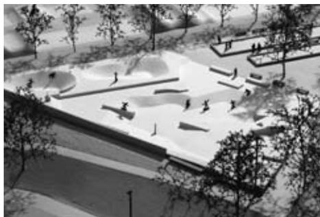
Die östliche Anlagenbegrenzung gegen die Wohngebiete erfolgt aus schalltechnischen Aspekten mit einer bis 2,0 m hohen Betonmauer, die in den Hinderispark integriert ist.
