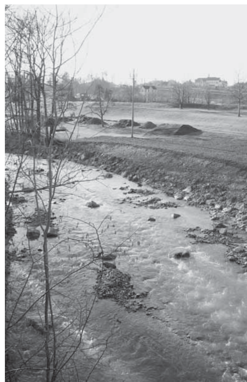
Sanierter Abschnitt der Goldach
