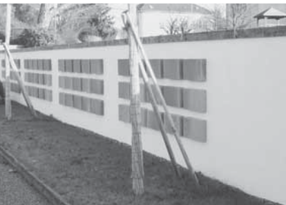
Die neue Urnenwand ist ge-baut.
