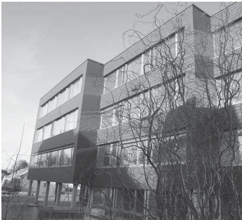
Die Sanierungsarbeiten am Bachfeldschulhaus sind schon bald abgeschlossen.
