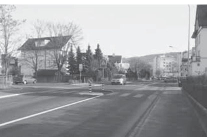
Der Fussgängerübergang über die Tübacherstrasse ist baulich verbessert.
