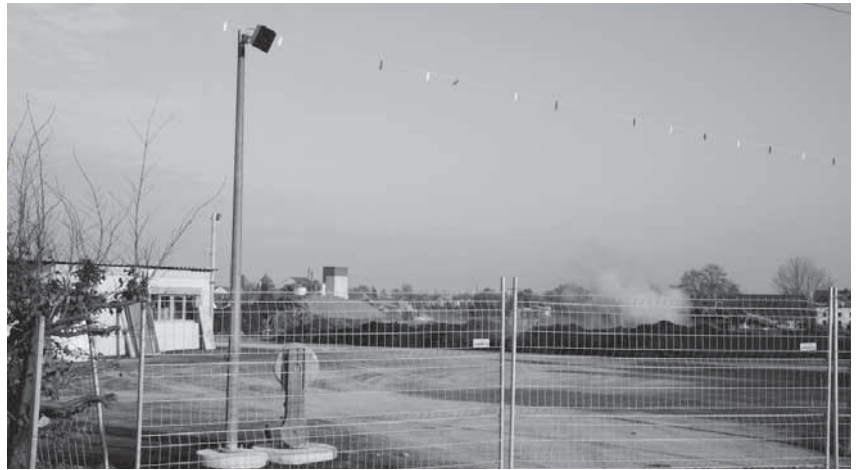
Die neue Kompostieranlage in Steinach.
