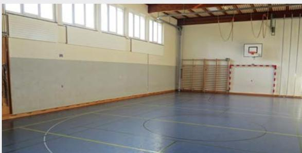
Die Hallenböden entsprechen nicht mehr dem Stand der Technik. Sie weisen zudem Beschädigungen und Ablösungen auf. Auch sind die Markierungen abgenutzt.
