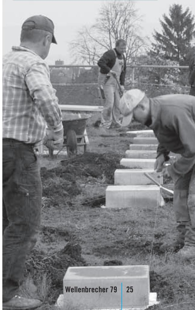
Einmessen der Betonsockel auf dem Dach des Wartegg-Schulhauses. Diese dienen der Befestigung der Solarpennel.
